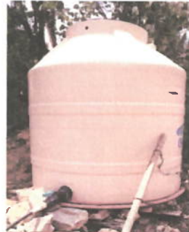
Foto 2: REPARACIÓN Y MANTENIMIENTO DE CISTERNA/DEPÓSITOS DE AGUA Sustitución de cisterna y accesorios de tanque de almacenamiento de agua.
