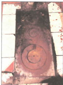
Foto1: REPARACIÓN O SUSTITUCIÓN DE ÁREA DE COCINA sustitución de estufa rural con chimenea, plancha y accesorios.
