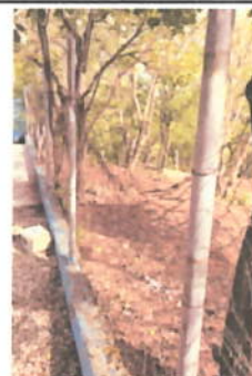
Foto 6: CERCO O MURO PERIMETRAL
