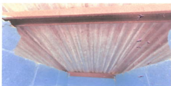
Foto 3: CUBIERTA DE LAMINA
